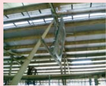
夏場対策でメーターファンを下向きに角度をつけて設置
