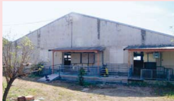
陰圧換気方式のトンネル換気豚舎*に改造
