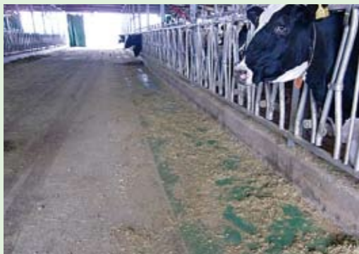
飼槽レジンの塗布で表面をなめらかにする
