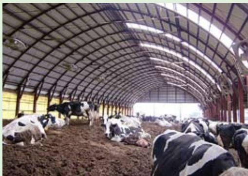
換気扇の設置
