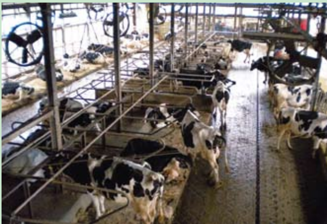
換気をよくするため、天井を高くし換気扇を設置した牛舎
