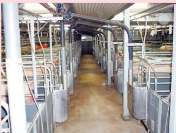
写真3：分娩舍内に設置されたリキッド給餌ライン
