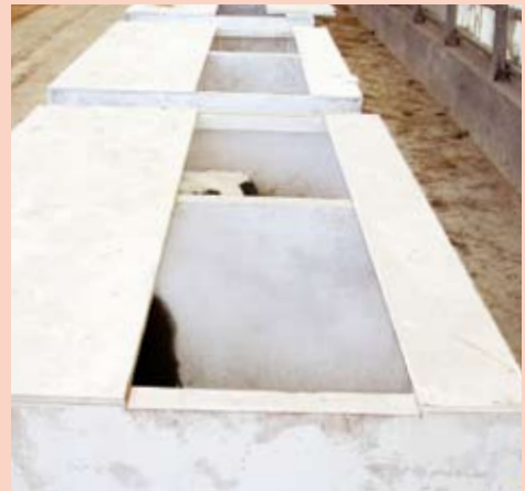
写真5：換気のために開けたハッチ天井部
