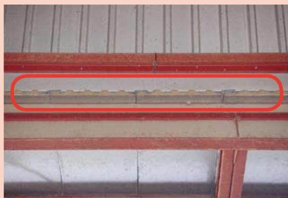
写真3：断熱材の設置
