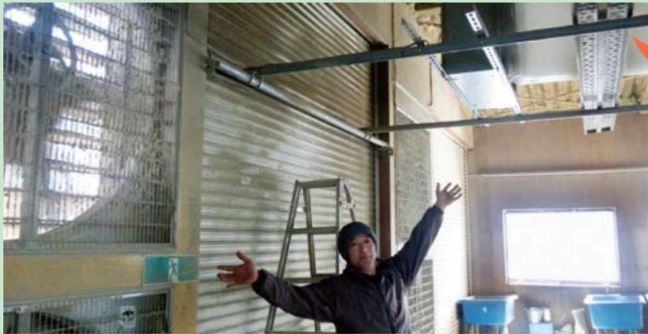
写真4: トンネル換気の排気口（左側）とダクト換気の吸気口（右側）
