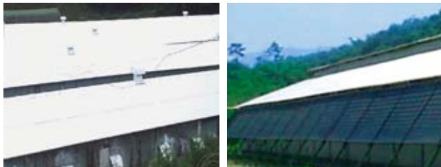
屋根を石灰乳で白く塗り、表面の温度上昇を防ぐ
