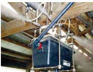
細霧装置の設置で冷却効果をねらう
