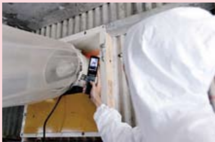
スモークテスターから出る白煙がファンに吸引される様子を確認する(写真上)ことで、豚舎の内外をつなぐ換気ファンの機能を確認し、汚れた空気を循環させていないかを調べる
