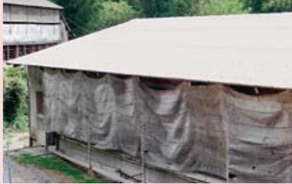
石灰を塗布した屋根と遮光ネットにより太陽光の侵入を低減している
