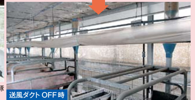
特定の場所にだけ風を送りたい分娩舎では、送風ダクトの吹き出し口や母豚の首筋部分への風速を測定
