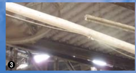
写真3. 非常に細かいミストを発生する。すぐに蒸発するので水浸しにはならない
