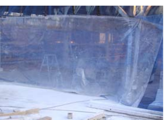
写真1. ビニールフィルムを張りつけた風除け対策
