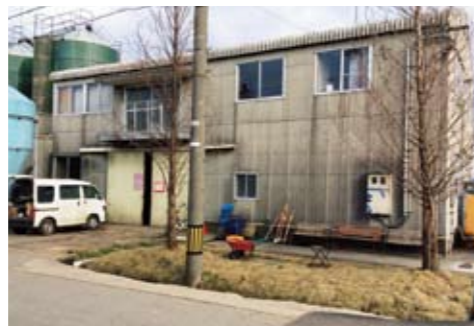
写真4.以前は排気ダクトの少ない牛舎構造だった
