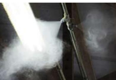
写真3. 牛房の上に備え付けられた噴霧装置からは2方向にミストが噴射される
