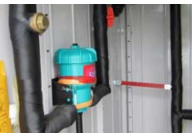
写真2. 消毒薬と希釈用の水を一定の割合で配合する配管
