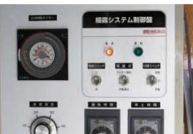
写真1. 自動噴霧装置の制御盤。タイマーを設定し、一定の時間がくると消毒液を噴霧するシステム
