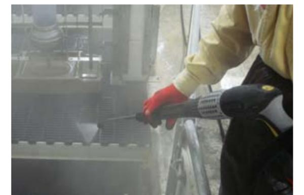
写真2. 高圧洗浄機による温湯洗浄 (湯気がたっている)
