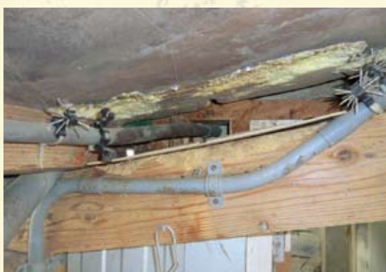
写真3.侵入防止用の資材で遮断している様子
