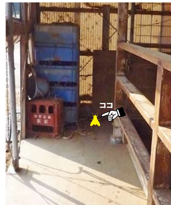
写真2. 乳牛舎内側、隅の部分
