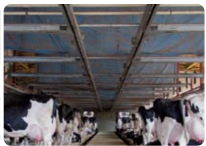
写真1,2. トンネル換気の採用で、牛舎の断面を遮る壁を設置している
