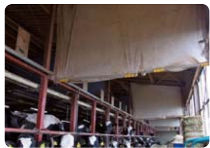
写真1,2. トンネル換気の採用で、牛舎の断面を遮る壁を設置している
