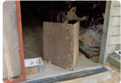
写真3. 入気口が狭い牛舎では、板を配置し牛体に風が流れるように工夫されている
