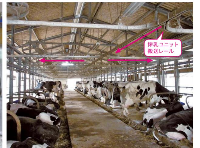
写真1. 牛舎内に張り巡らせた搾乳ユニット搬送レール
