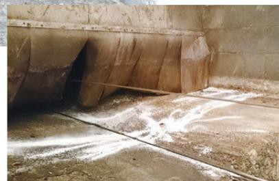
写真3. ホウ酸を散布したスクレPPER開口部
