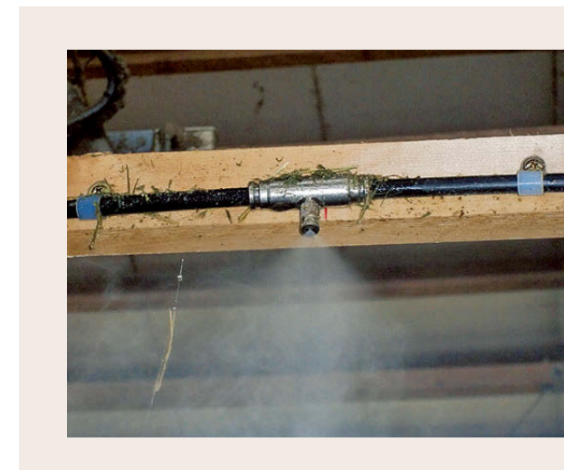
写真1.牛舎内に設置した細霧装置から発生するミスト
