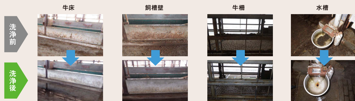
図.洗浄前と洗浄後の状況
