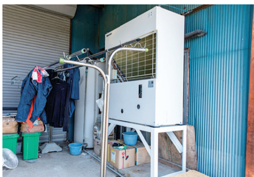
搾乳用器材を高い位置に設置し、浸水リスクに備える
