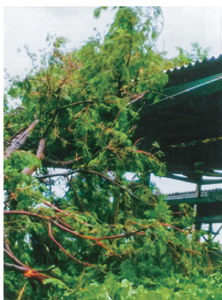
写真1. 倒木が直撃した畜舎の屋根
