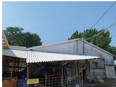
塗布作業後の畜舎の屋根
