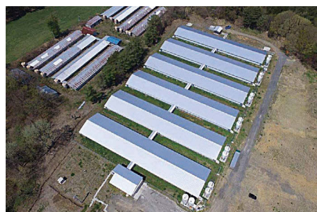
写真2. 畜産クラスター事業を活用して新設した豚舎
