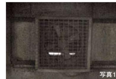
本来シャッターは、換気扇が止まっている時に冷気が流入しないために付属している。しかし、一部でも欠落することで機能しなくなり、換気扇の周辺だけが換気される「ショートサーキット」現象が生じてしまう。「すきま風」の有無に敏感になるなど、気密性にかかわるパーツの点検は特に注意して行いたい。
