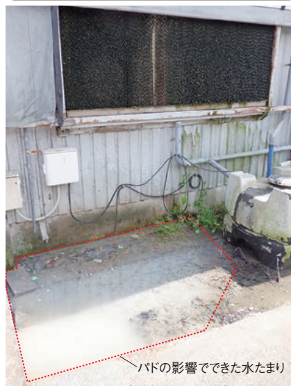
写真1 パドの下にできた水たまり
