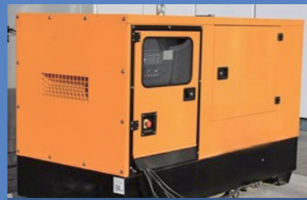
非常用発電機
