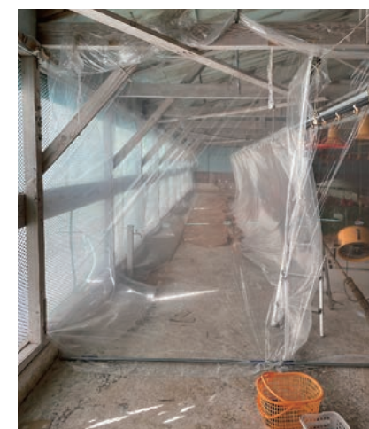
写真3. 二重カーテンで空気の層を作った様子
