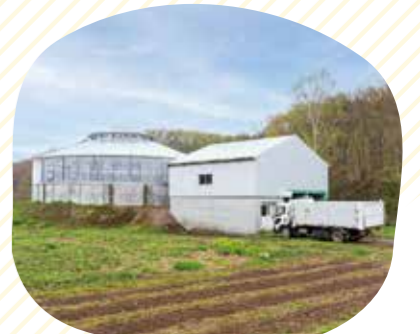
豪雪対策のため屋根のある浄化槽
