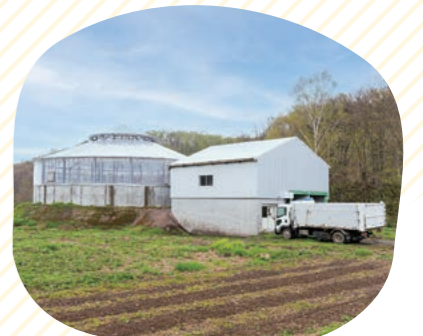
豪雪対策のため屋根のある浄化槽
