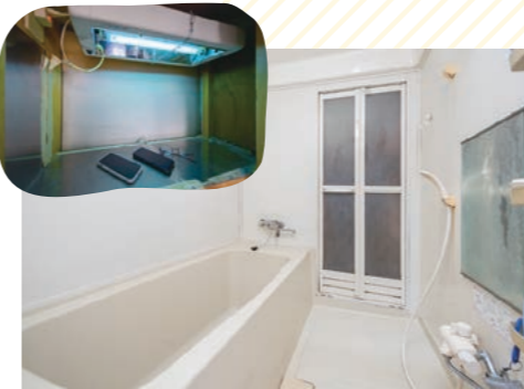
きれいに保たれたシャワー室。紫外線で豚舎への持ち込み物を殺菌するスペース(写真左上)
