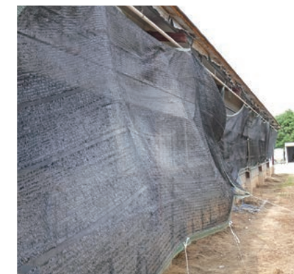
写真2 豚舎における暑熱対策 豚舎カーテンの外側に設置した寒冷紗
