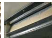
写真3 ホコリが付着した天井インレット
