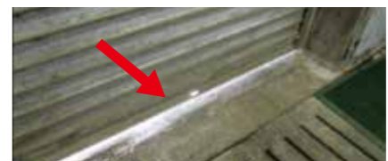
写真6 ドア下の隙間にはゴム板などを設置し、すきま風を防止
