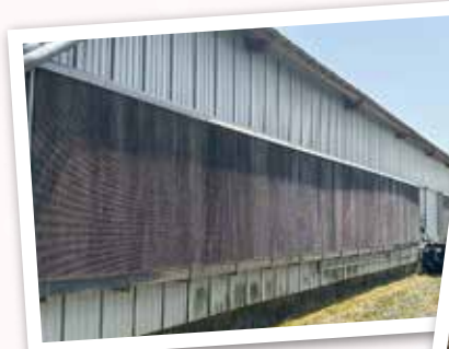
気化熱を利用するクーリングパッドで豚のストレスを軽減
